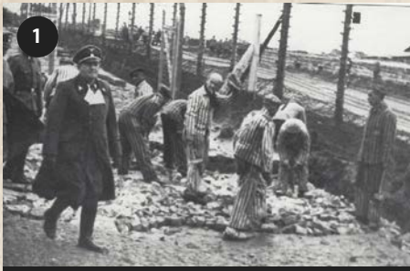
1 Les SS surveillent la construction des fondations des murs, 1941
